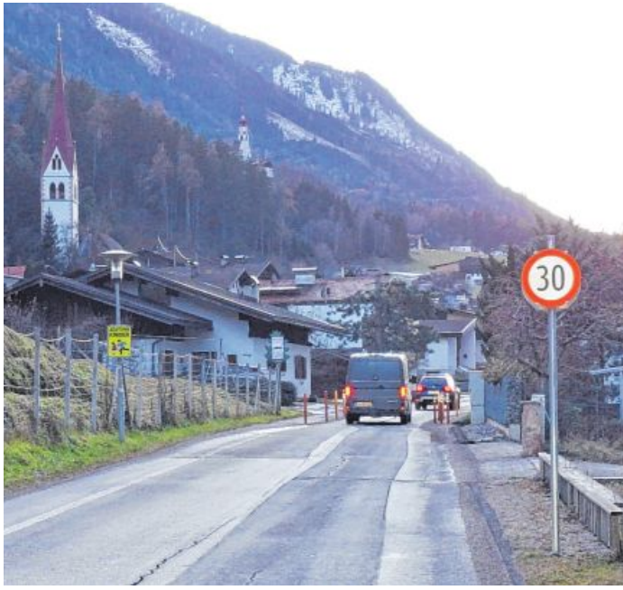
Die 30er-Tafel war schon vor dem Beschluss im Rietzer Gemeinderat am Dienstagabend angebracht. Foto: Paschinger
