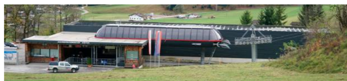
Mit Hochdruck wird daran gearbeitet, die Hahnenkammbahn in Höfen für den Winter vorzubereiten. Fotos: Reichel
